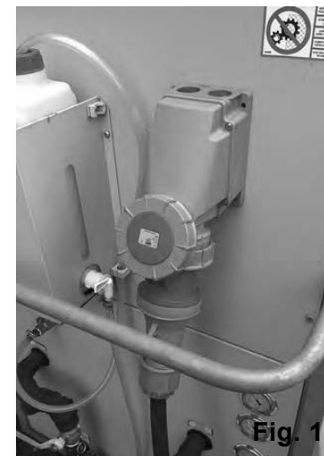
Fig. 1 - Connecteur d'entrée 400 volts, 63 ampères, 5 pôles, qui se trouve sur le groupe froid de 50 KW
